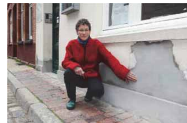
Ulrike Mechau-Krasemann zeigt den Wasserschaden am Künstlerhaus, innen ist eine große Baustelle.
